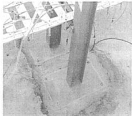
图 3.4 塔柱与底板的连接
